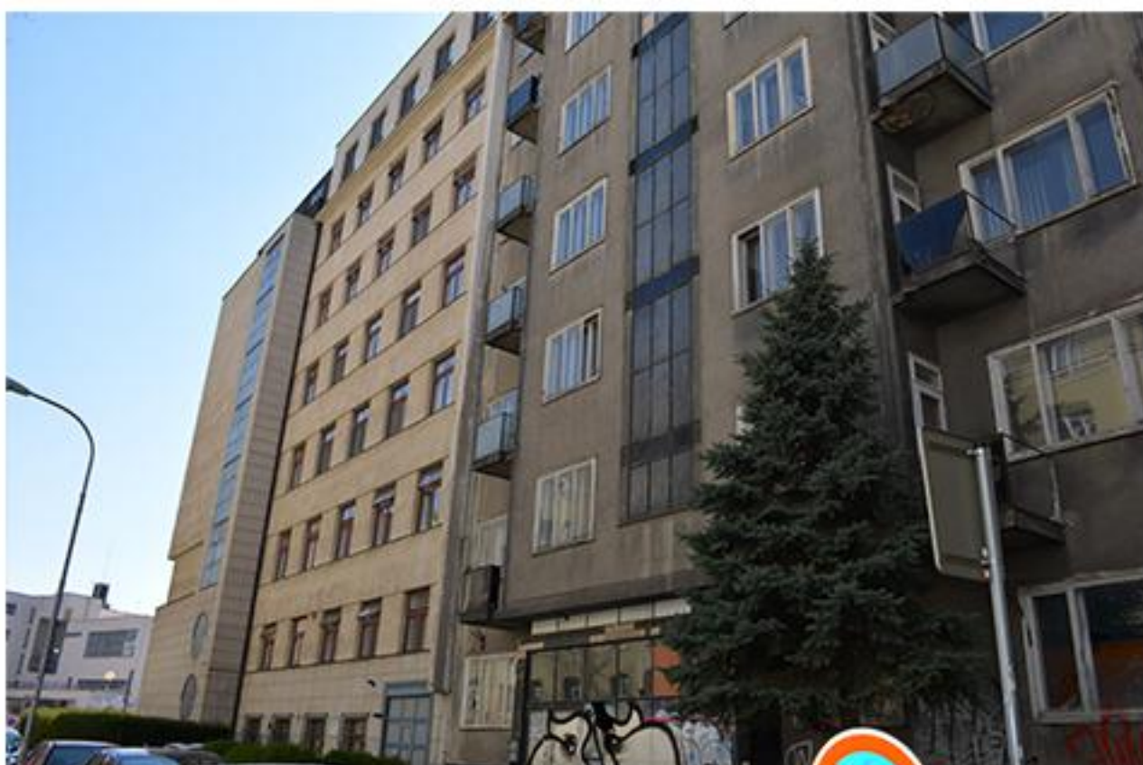
Starý obytný dům v ulici Bayerova 3 před zahájením demolice
