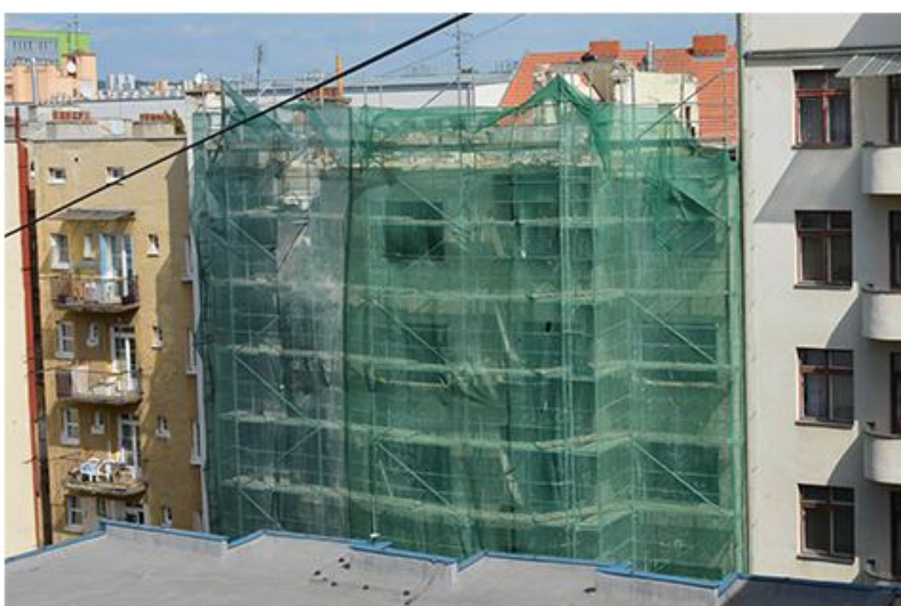
Záběry na demolici z vnitřního traktu budovy Nejvyššího soudu (září 2017)
