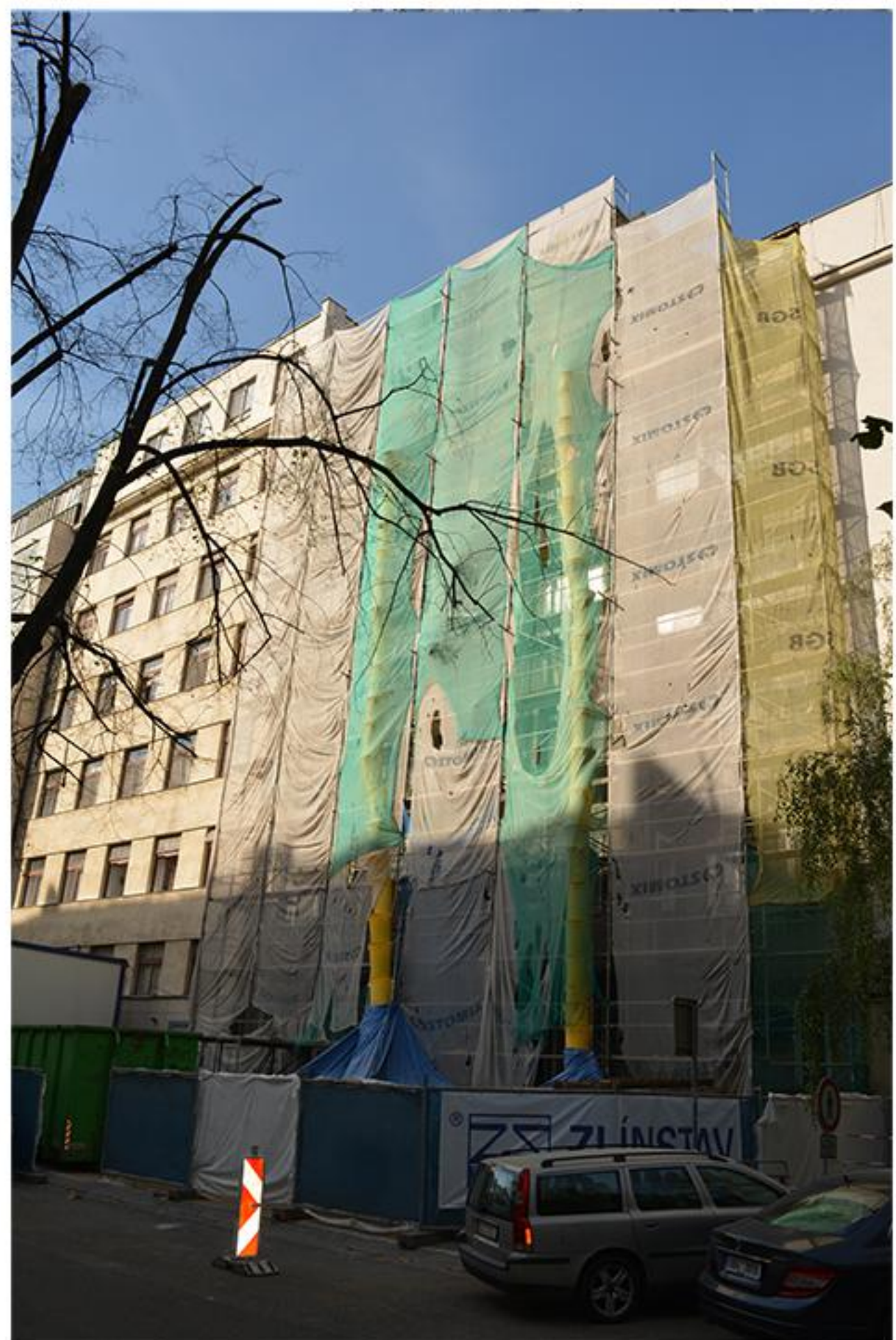
Demolice zahájena odstraněním střechy (srpen 2017)
