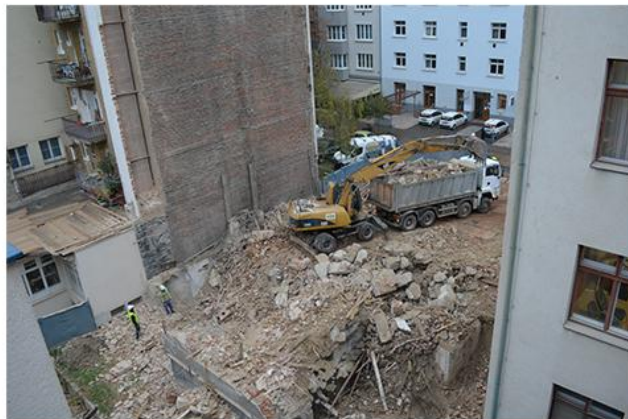
Odklizení posledních zbytků stavby (pohled z dvorního traktu budovy NS)
