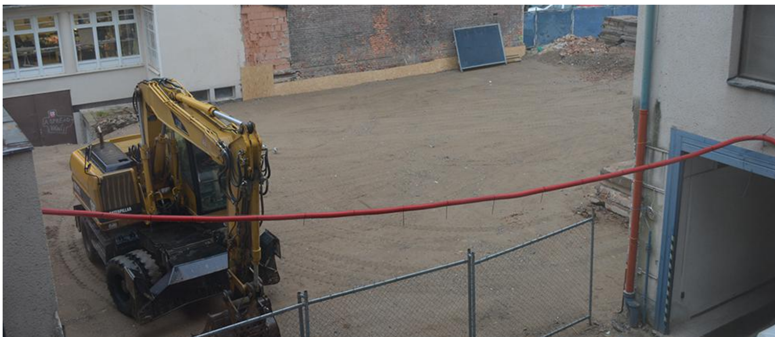
Aktuální pohled na staveniště v polovině prosince 2017
