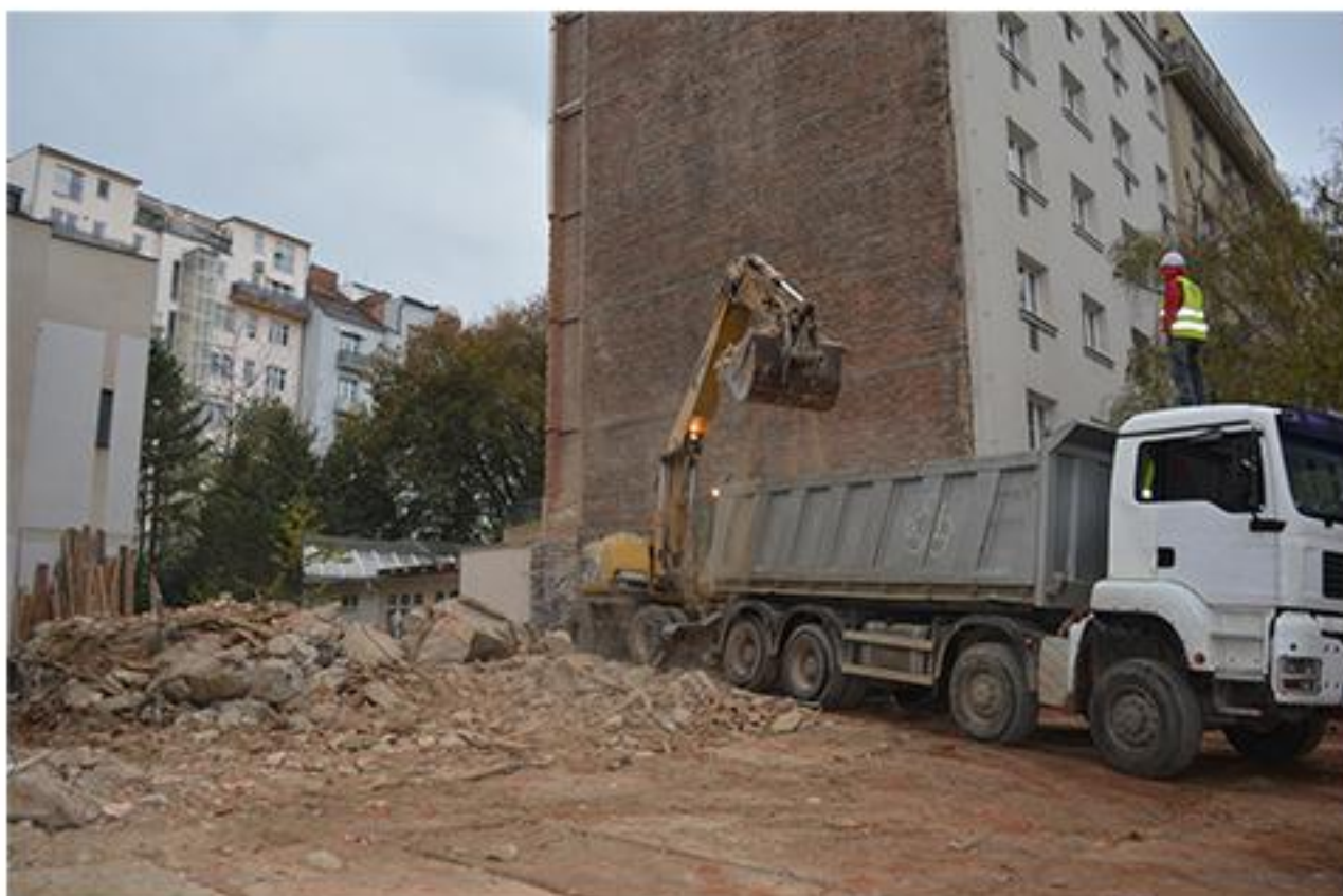
Odklizení posledních zbytků stavby
