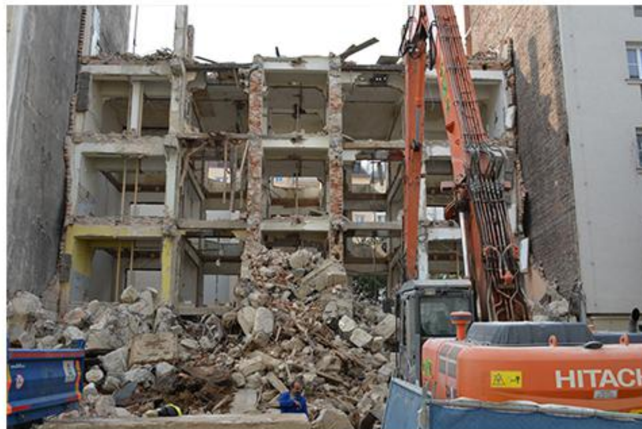
Ruční rozebírání stavby nahradila demolice těžkou technikou (říjen 2017)
