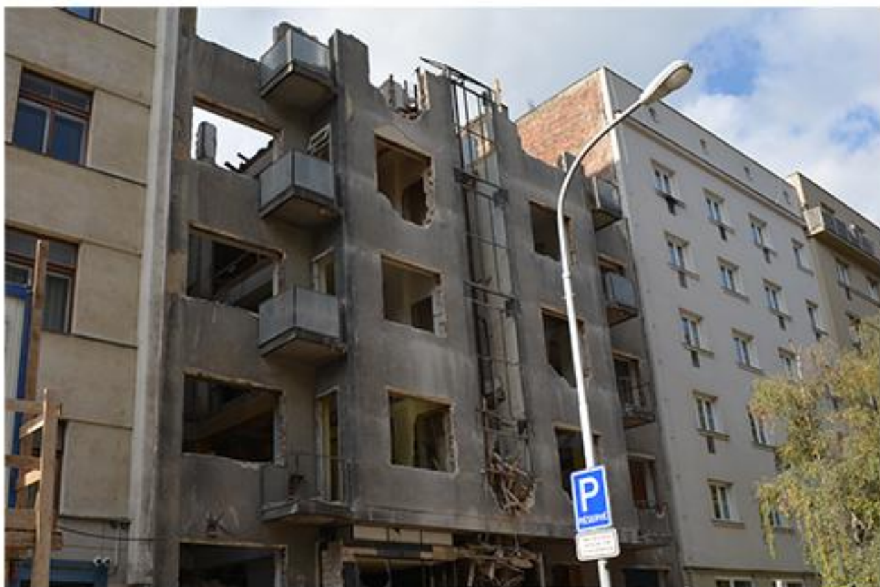
Demolice podstatně pokročila na počátku října 2017
