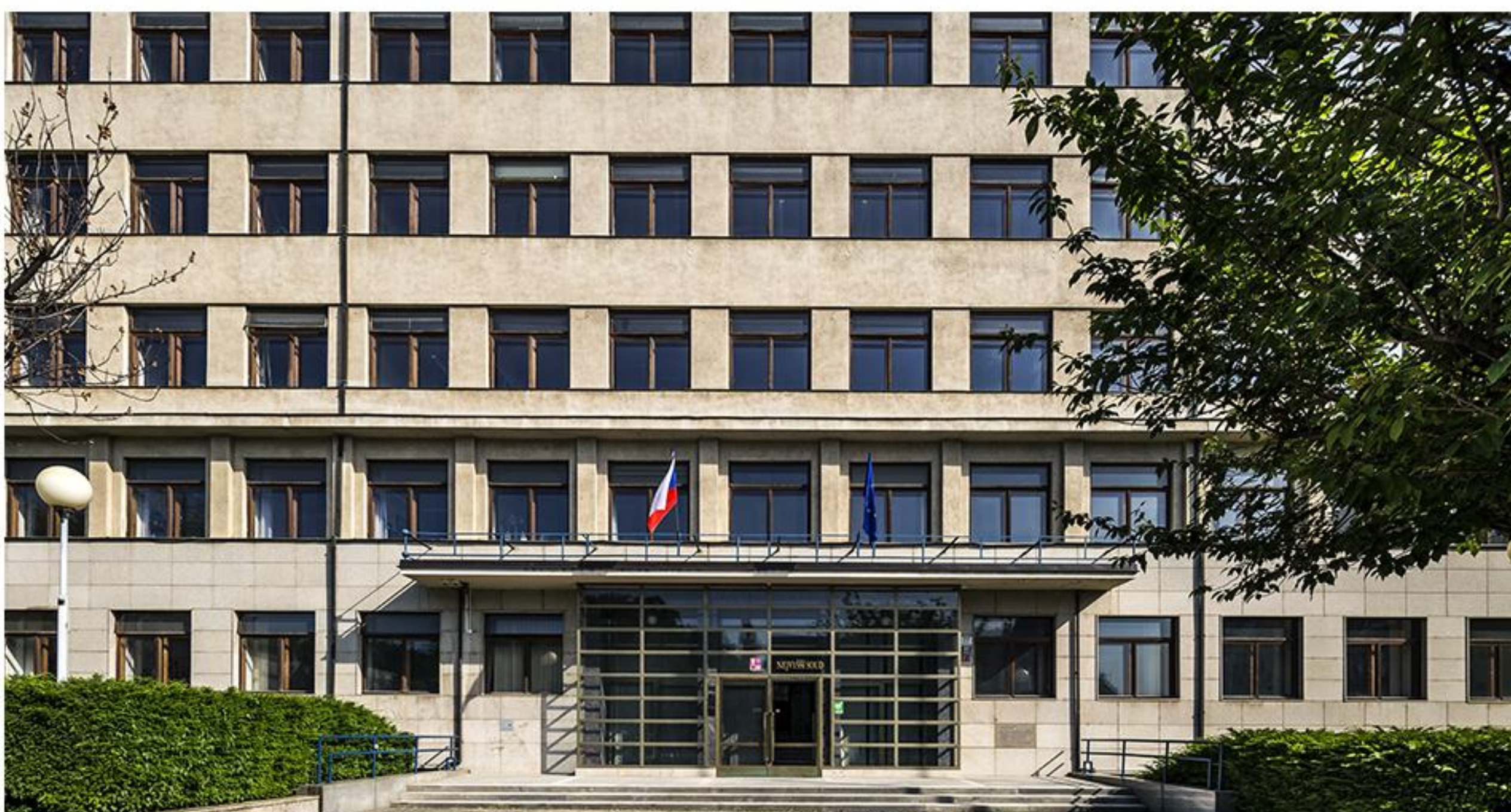
Budova Nejvyššího soudu (2018)
