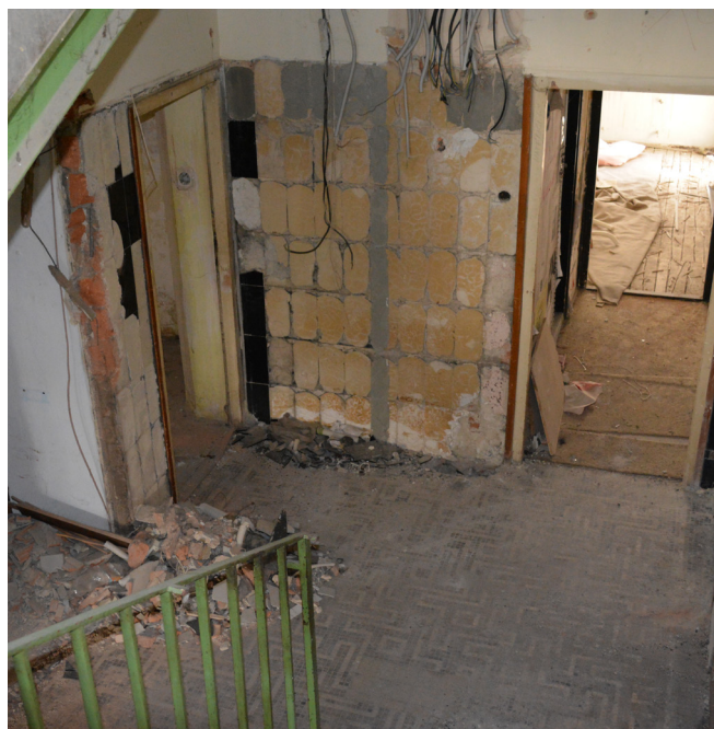
Na některých chodbách po vystěhování bývalých nájemníků nezůstaly ani obklady
