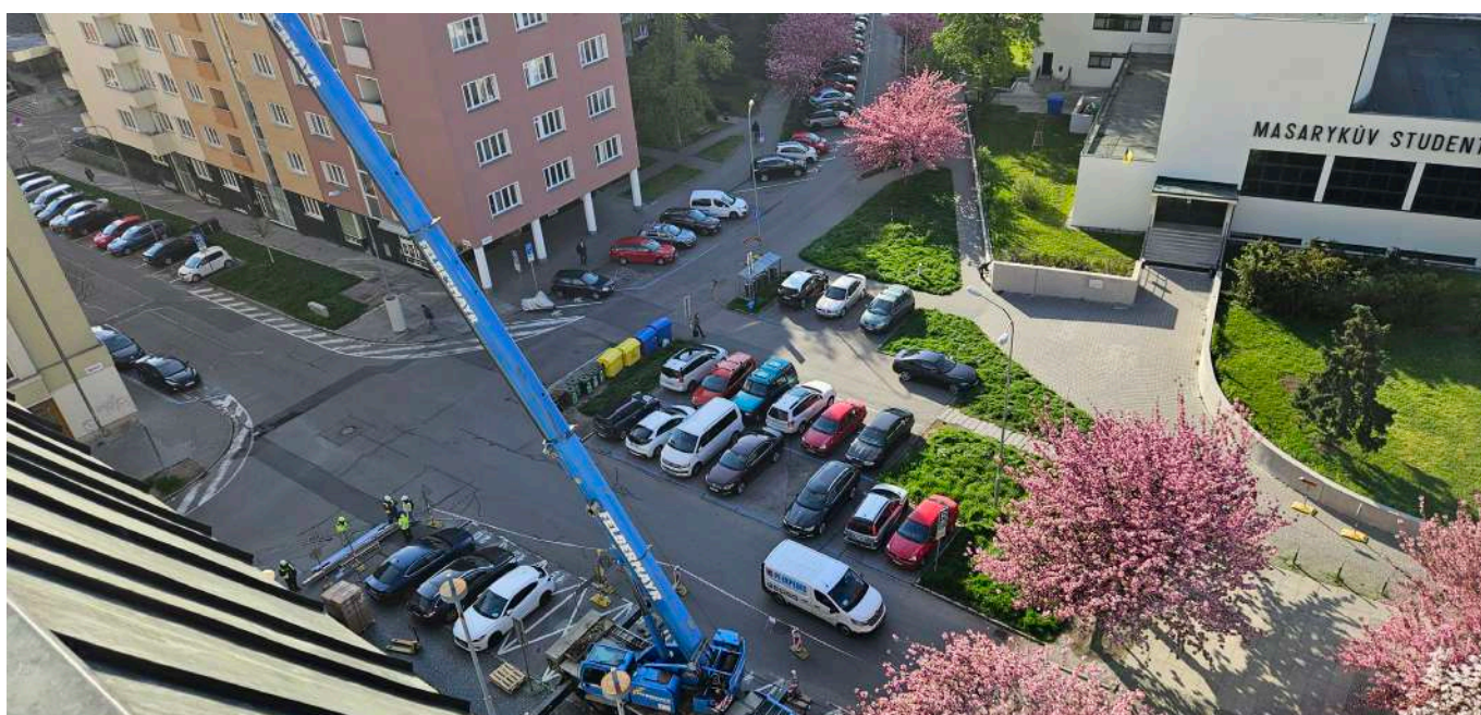
Pohled ze střechy budovy Nejvyššího soudu.
