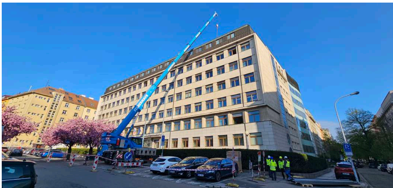
Instalace kondenzační jednotky na střechu budovy Nejvyššího soudu.
