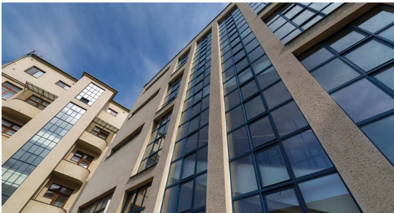
Zadní stěna budovy Nejvyššího soudu, vlevo typické půlkulaté balkóny
