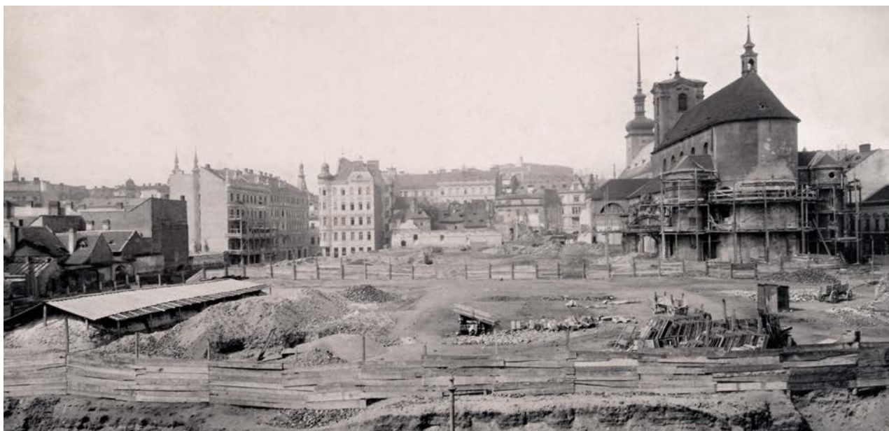
Staveniště na místě zbořené jezuitské koleje, kde byla následně roku 1908 dokončena stavba Justičního paláce v Brně (1905), Archiv města Brna
