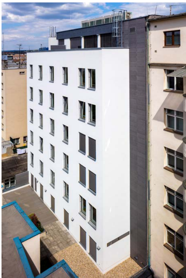
Nové křídlo historické budovy Nejvyššího soudu
