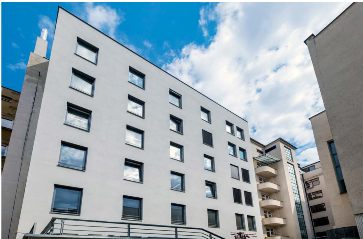
Nové křídlo historické budovy Nejvyššího soudu
